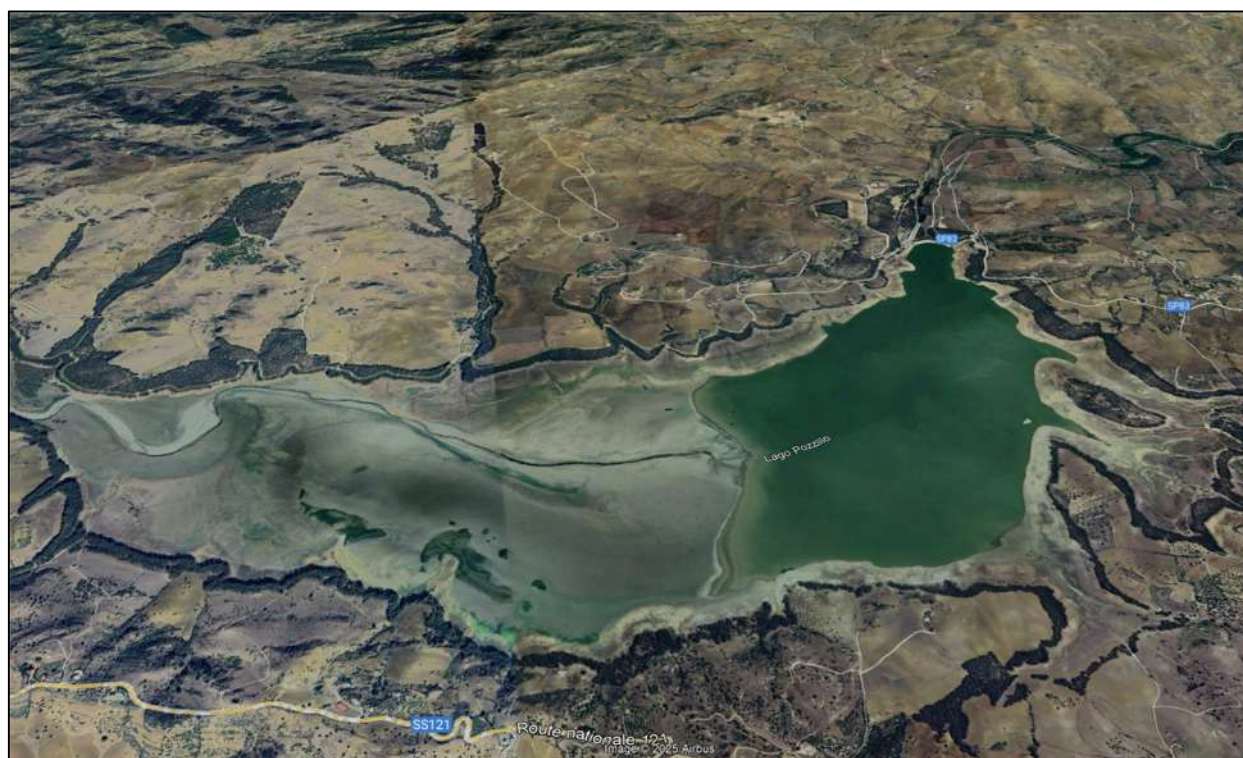
Figura 10 – Vista aerea 3D della diga Pozzillo
