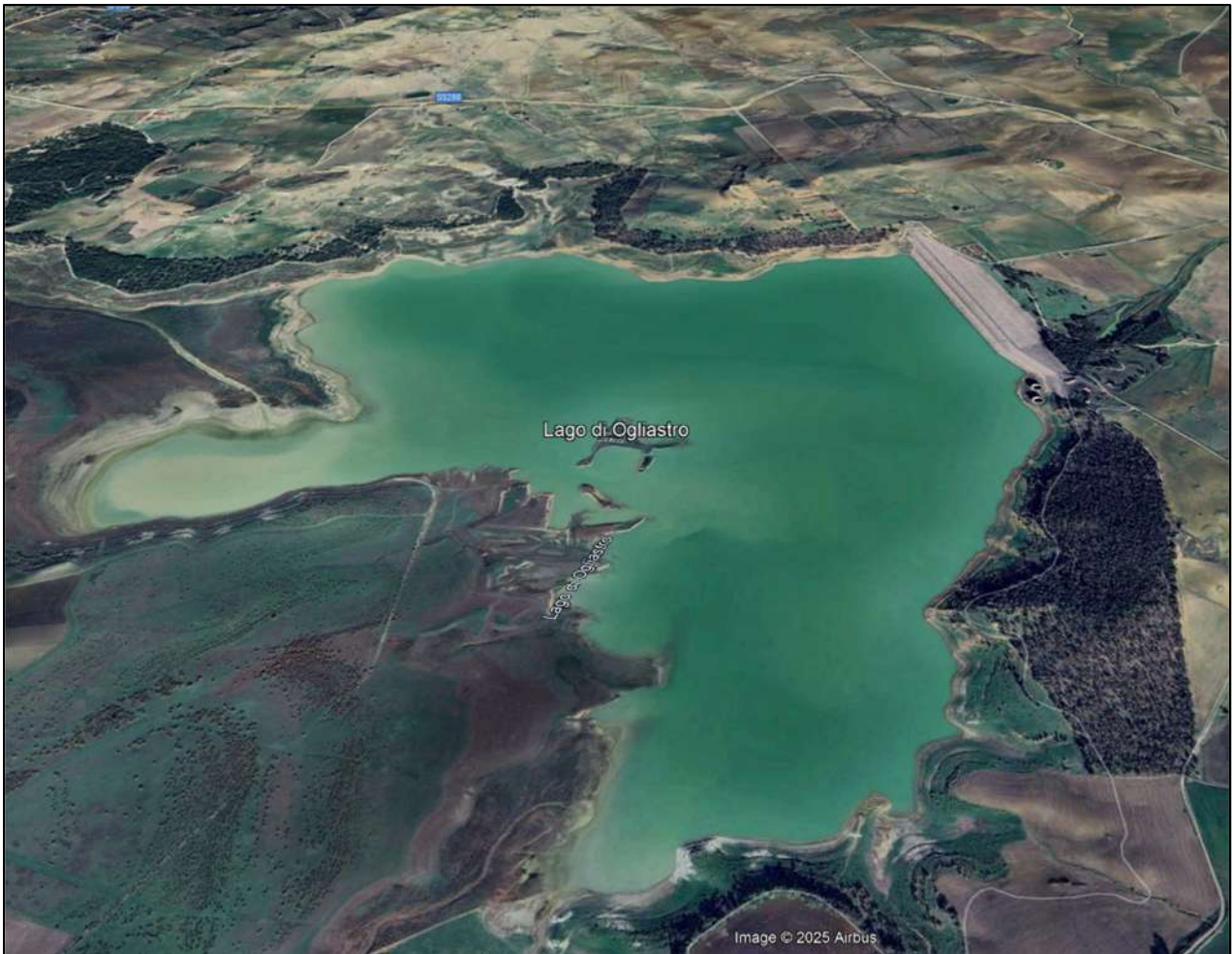
Figura 9 – Vista aerea 3D della diga di Ogliastro
